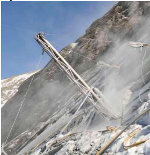
Durchführung einer 30 m tiefen Bohrung im Felspermafrost des Kitzsteinhorns
