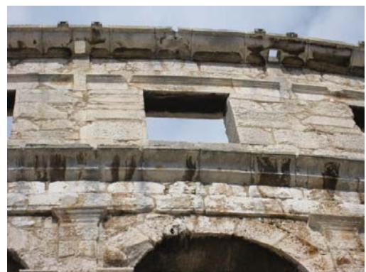
Abb. 4: Öffnungen für die Sonnenmasten
