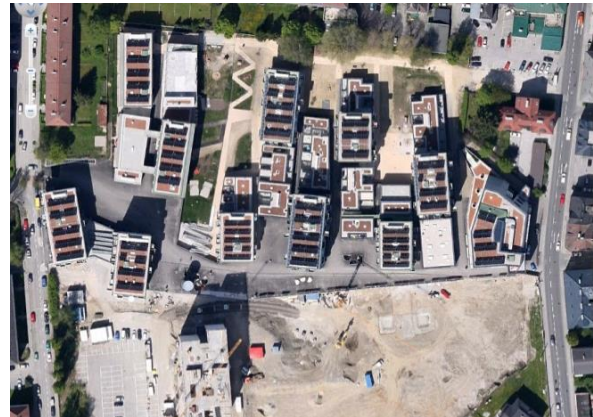
Stadtwerk Lehen, Nachverdichtungsprojekt mit großen ökologischen Defiziten (Quelle: Google Earth)
