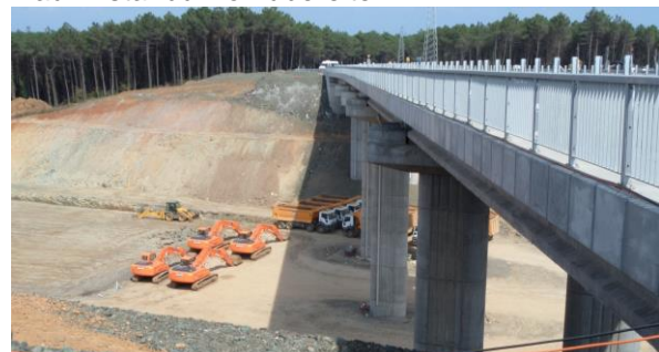
Neubau der Nordautobahn durch die letzten Waldbereiche im Norden Istanbuls
