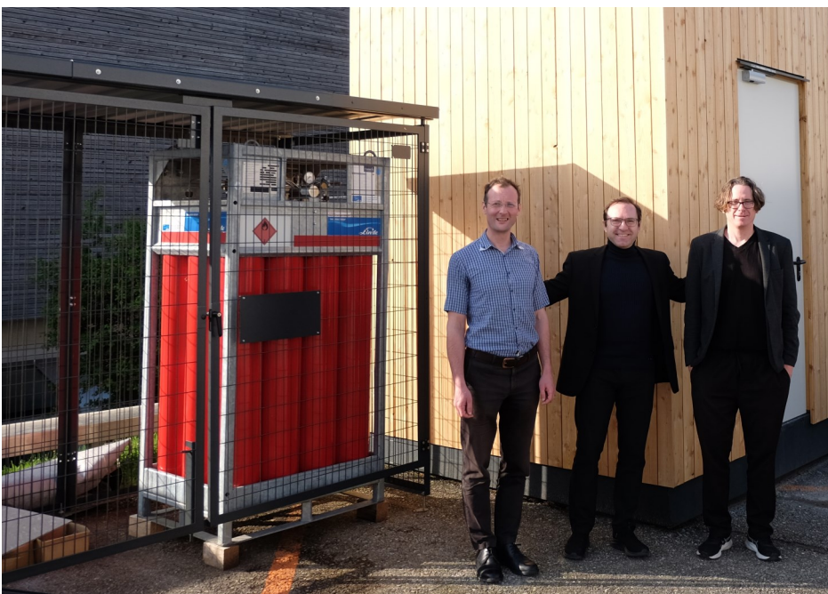
Abbildung 5: Elektrolyse-Anlage der FH Salzburg, Campus Kuchl
