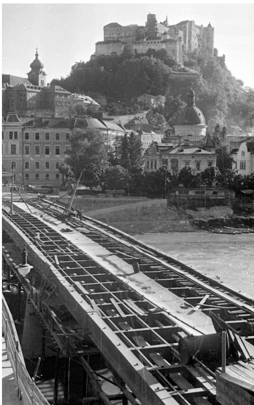
Abb. 3: Bauarbeiten an der Karolinenbrücke, aufgenommen am 6. Juni 1939. Auf der linken Seite ist der zur Aufrechterhaltung des Verkehrs flussaufwärts verschobene alte Teil der Brücke zu erkennen. Bei den Abschlussarbeiten 1940 kamen mindestens 10 Kriegsgefangene zum Einsatz.
